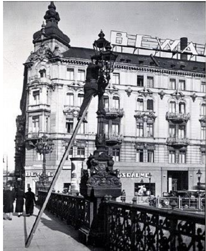
Wartung einer Straßenleuchte
