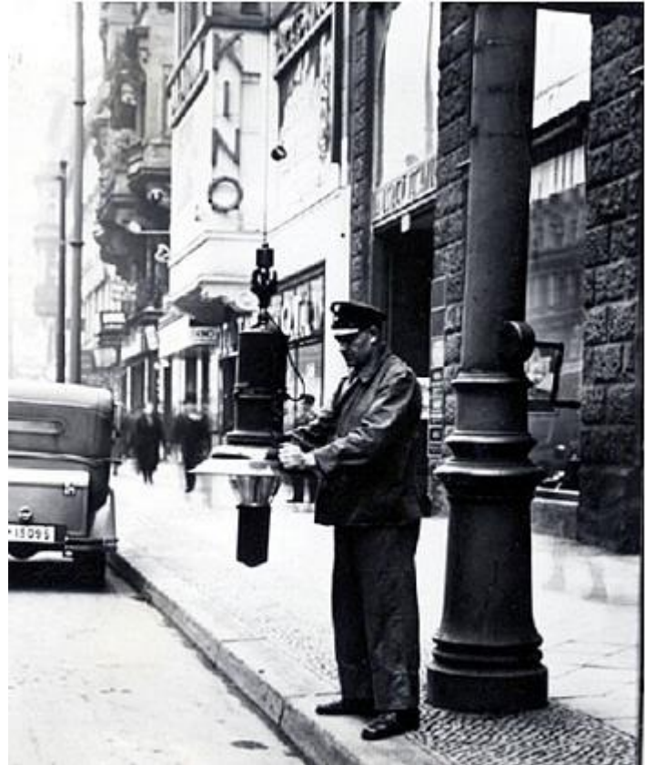
Wartung einer Kohlebogenlampe
