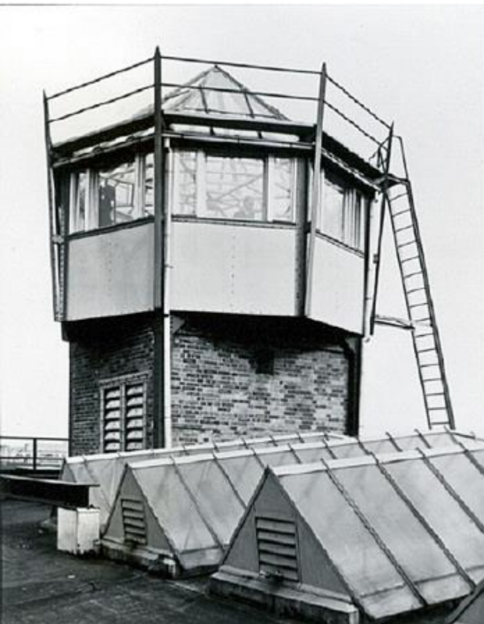
Lichtwarte auf dem Dach des Umspannwerks Scharnhorst
